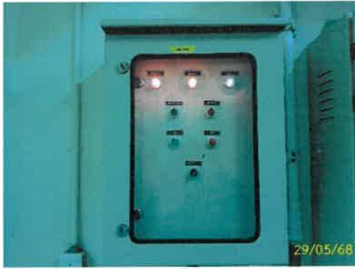
ตู้ควบคุมเครื่องเติมอากาศ
