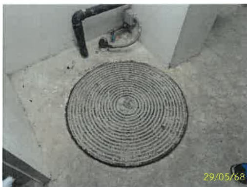
ฝาท่อเก็บน้ำฝนใต้ดิน อาคาร 7
