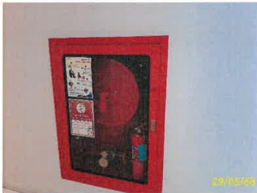
ตู้สายน้ำดับเพลิง และป้ายบอกวิธีการใช้อุปกรณ์
